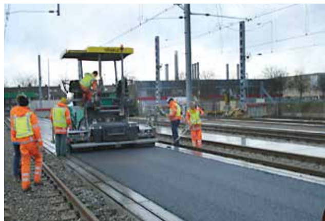
POSE D'ENROBÉ SUR LES QUAIS DE GARE
