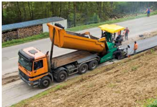
POSE D'ENROBÉ SUR TROTTOIRS/PISTES CYCLABLES COMBINÉS
