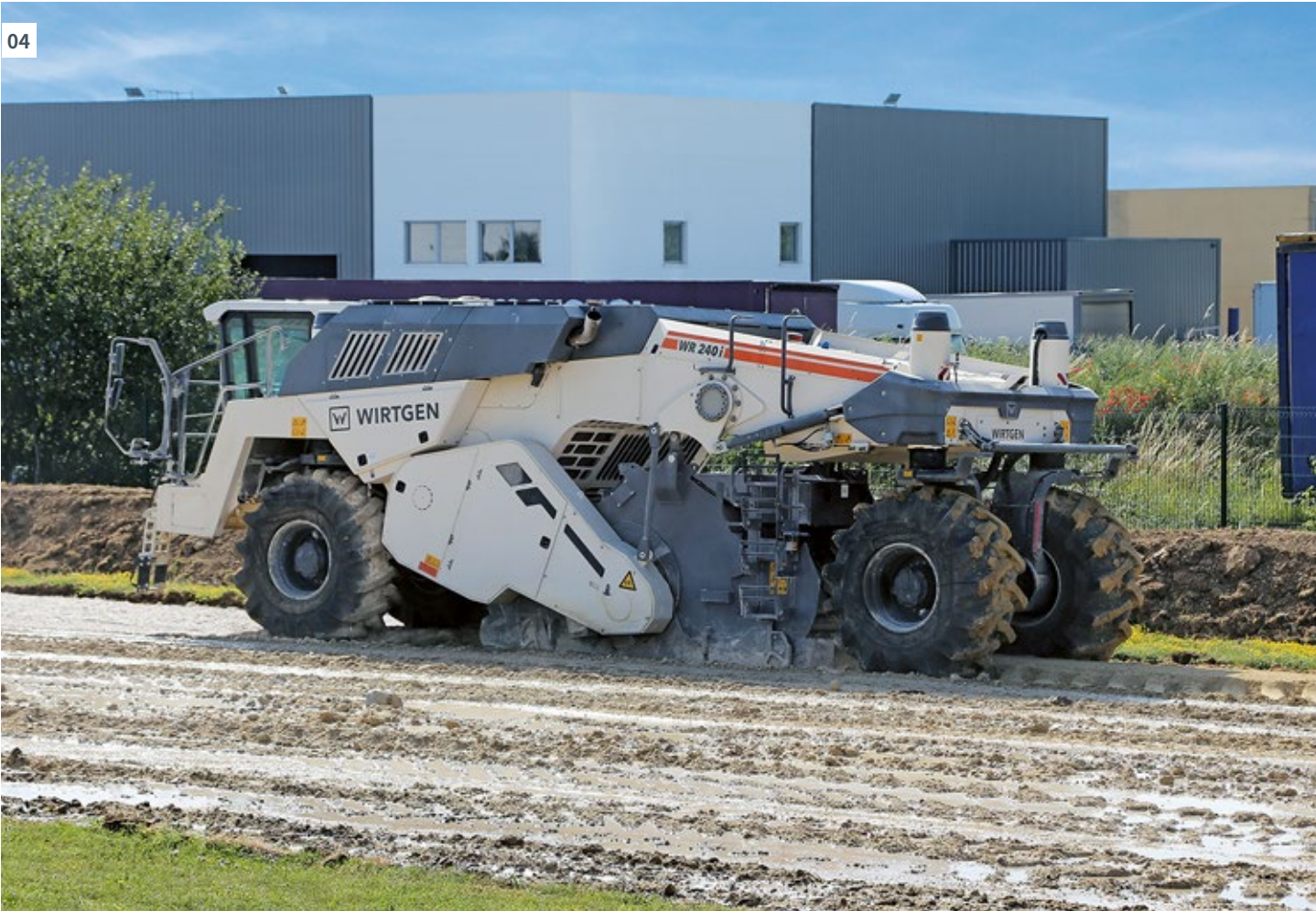
01-04 土壤稳定施工, 能够将承载力不足的土壤就地转换为优质的筑路材料, 直接用于摊铺和压实。
