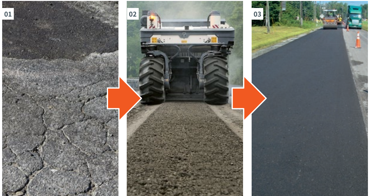
01 - 04 冷再生施工中，强劲的铰刨和拌合转子铰刨受损路面。破碎后的材料与喷入的粘结剂高效拌合，生成均匀的再生混合料，直接用于摊铺和压实。
