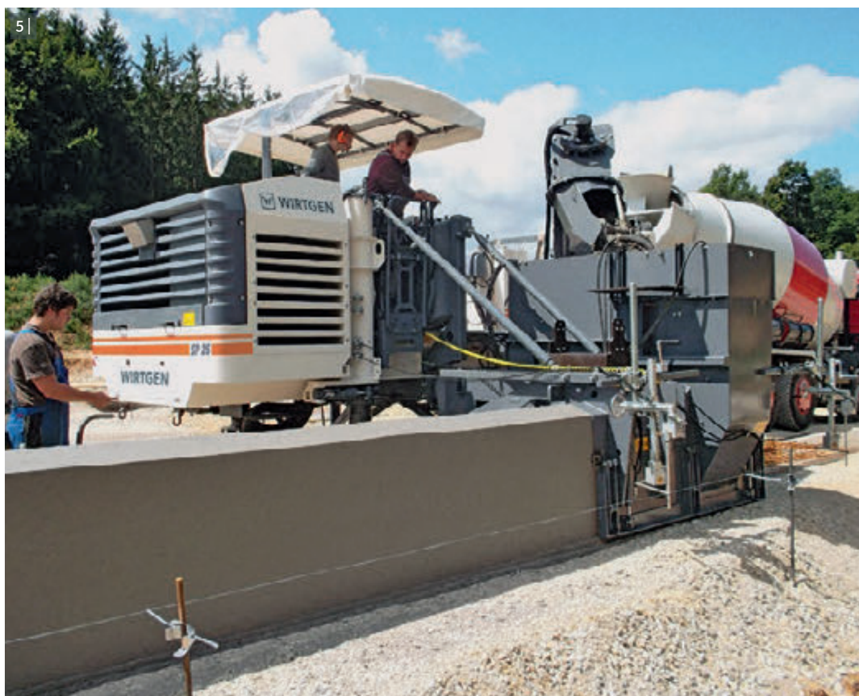
4-5 | 模具能安装在机器的左右任一侧，仅在很短的时间内，便能轻松完成机器改型。
