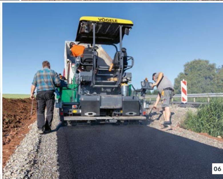
04 La plataforma del operador de la extendedora garantiza la máxima visibilidad. 05 Alimentación óptima con mezcla gracias a la gran tolva de material. 06 Combinable con la regla extensible AB 340.
