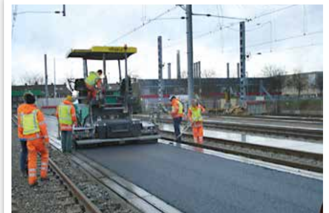
ASPHALTEINBAU AUF BAHNSTEIGEN
