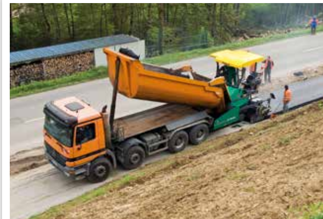
ASPHALTEINBAU BEI GEH- UND RADWEGKOMBINATIONEN
