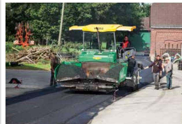
ASPHALTEINBAU AUF GEWERBLICH GENUTZTEN FLÄCHEN
