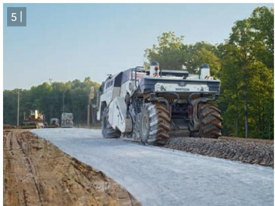
5 | Перед началом процесса стабилизации поверхность грунта предварительно посыпают либо цементом, либо известью.
