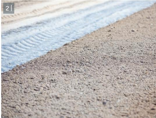
2 | Использование вяжущих позволяет оптимальным способом уплотнить грунт.
