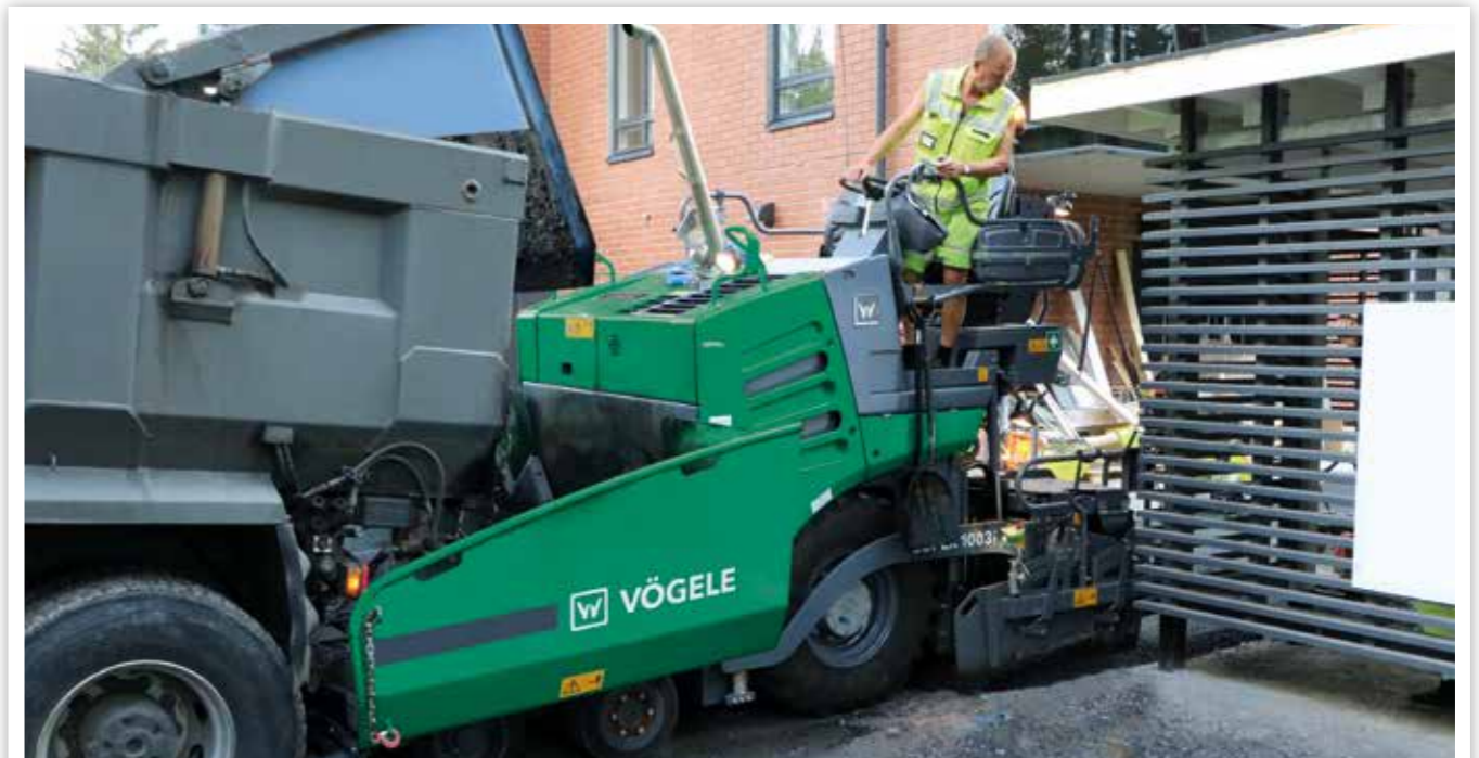
RIPRISTINO DI VIE DI ACCESSO
