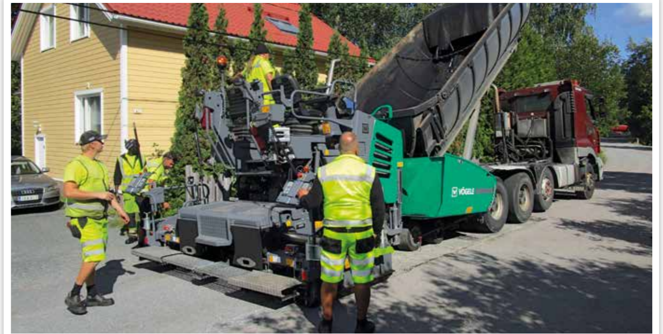
RIPRISTINO DI STRADE COMUNALI
