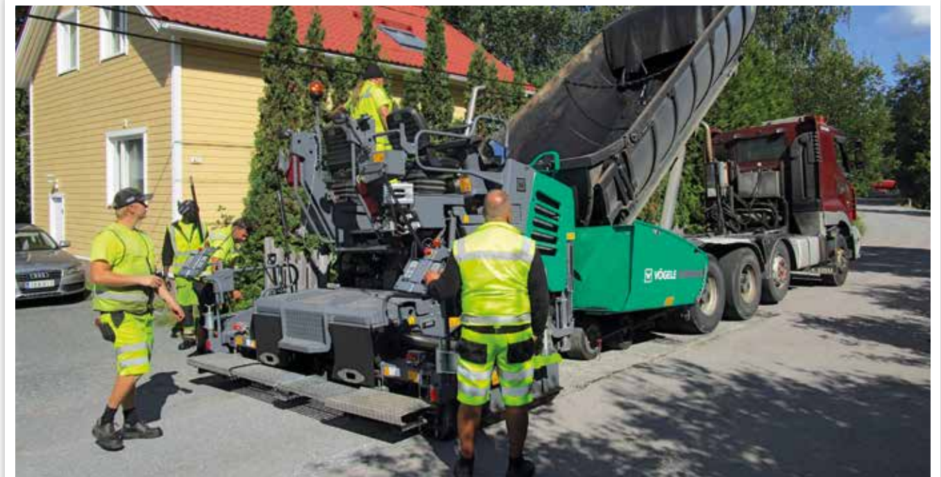
REHABILITACIÓN DE CARRETERAS MUNICIPALES
