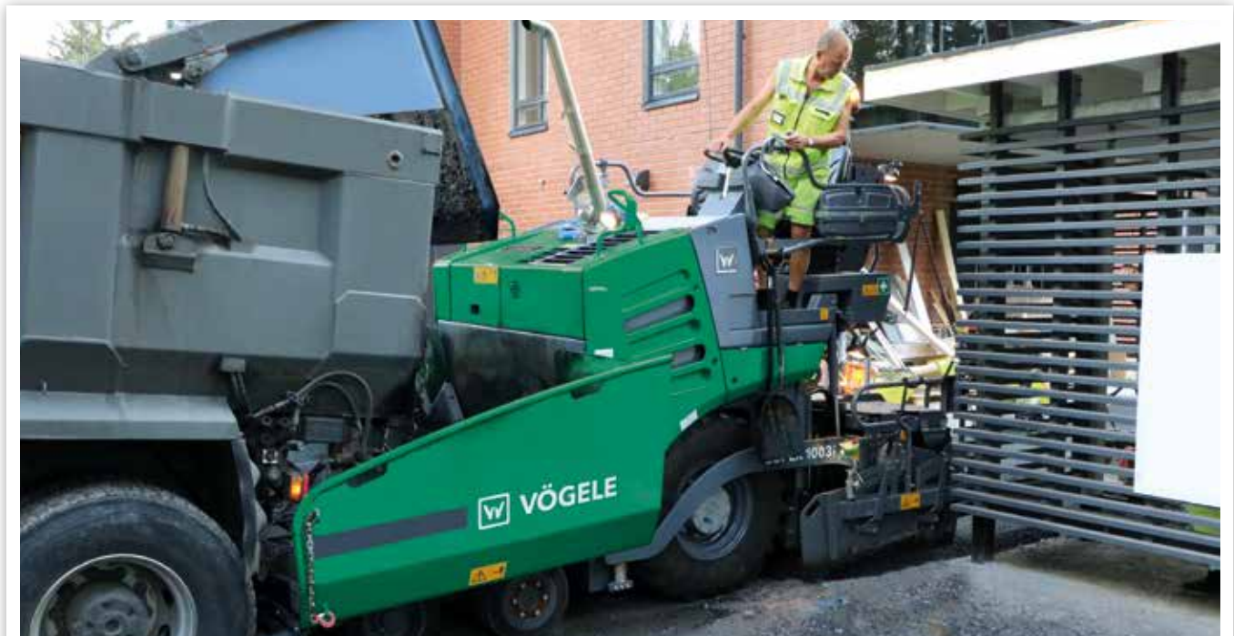
REHABILITACIÓN DE VÍAS DE ACCESO
