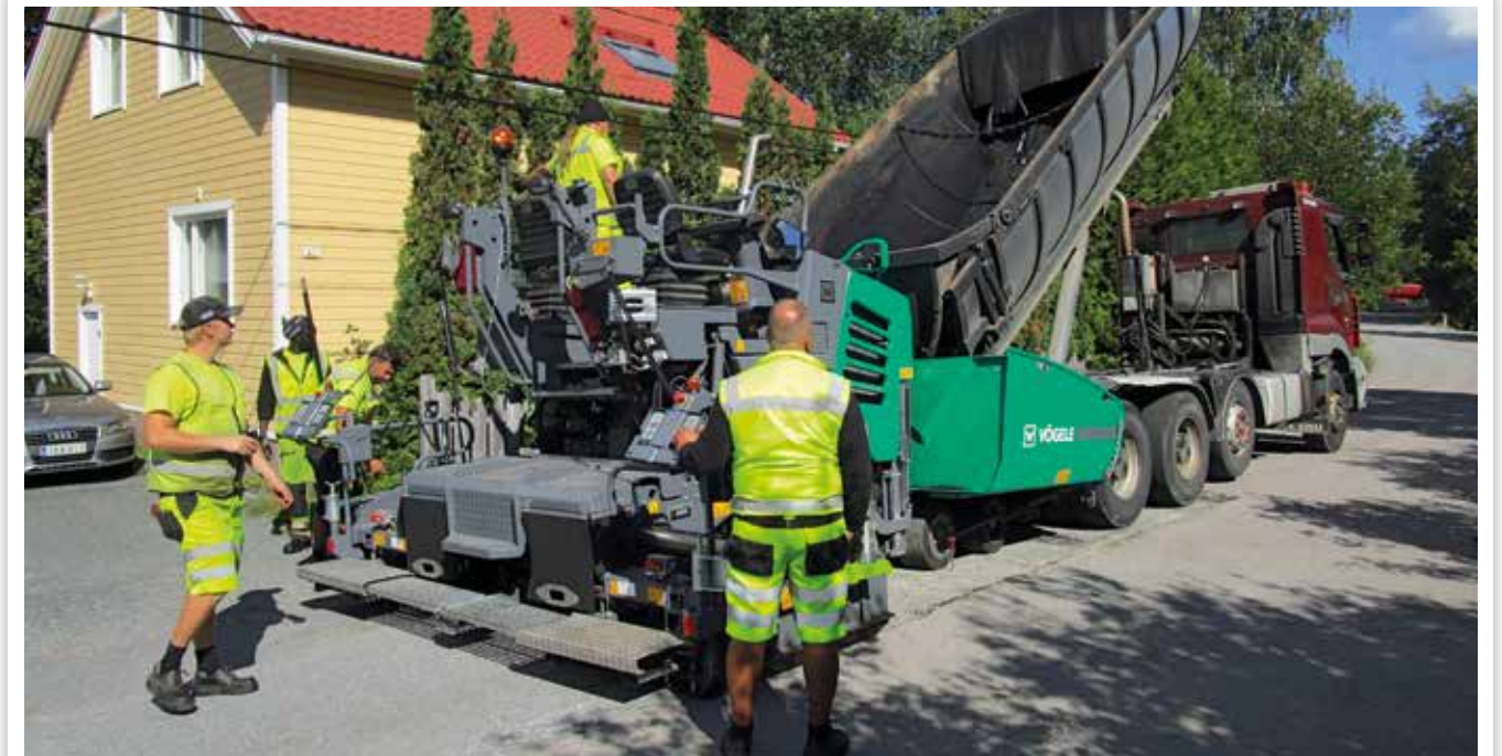
SANIERUNG VON KOMMUNALEN STRASSEN
