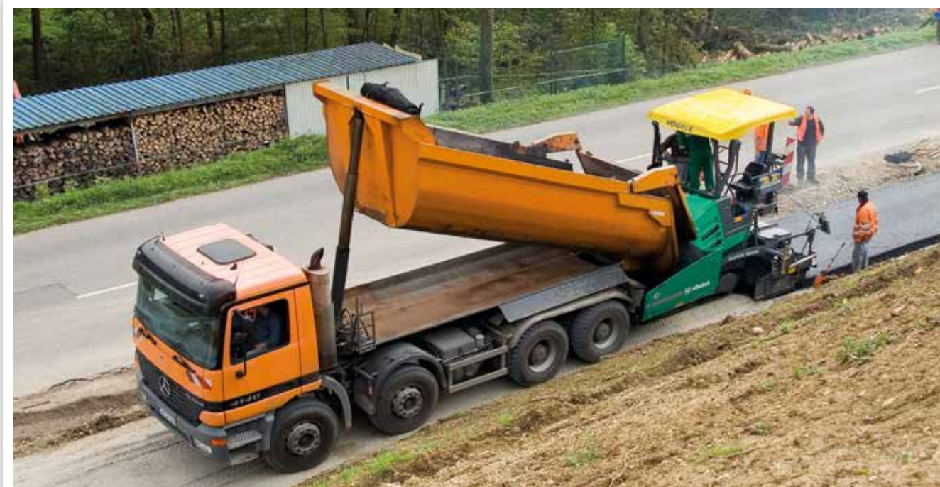
ASFALTATURA DI PISTE CICLOPEDONALI
