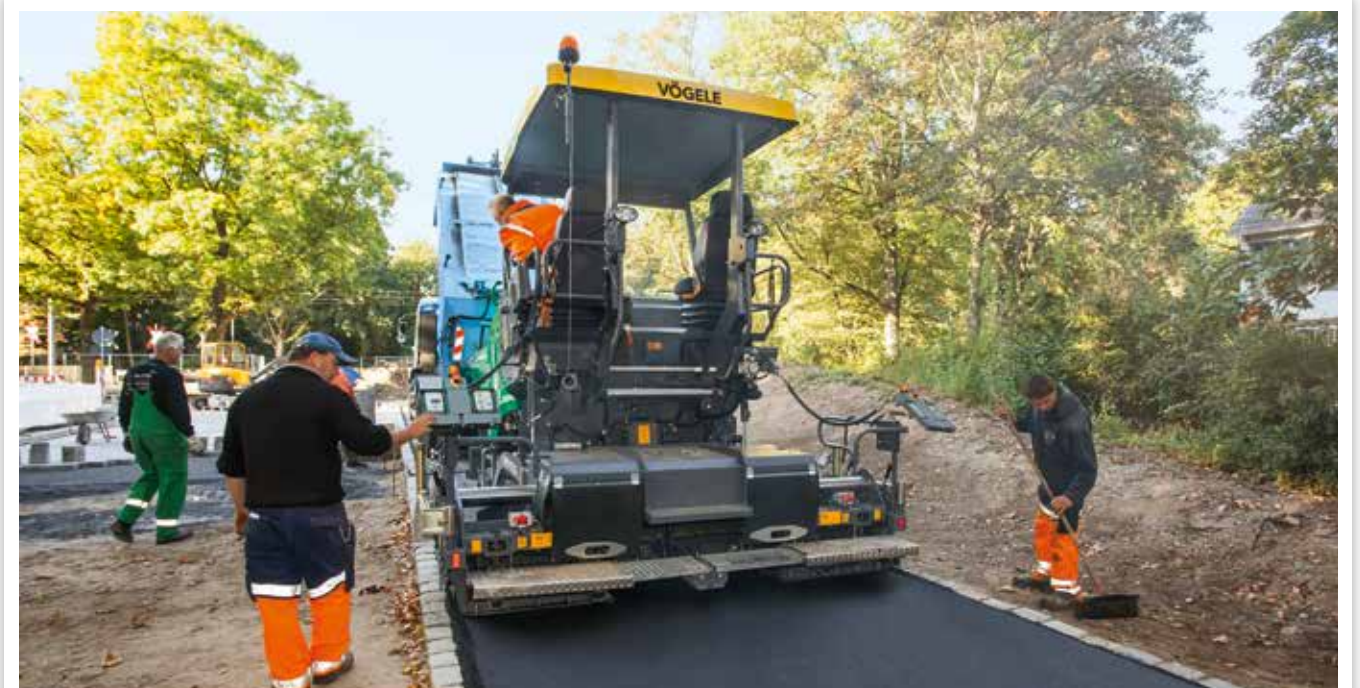
CONSTRUCCIÓN DE CAMINOS EN PARQUES
