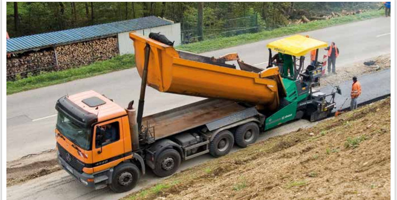
POSE D'ENROBÉ SUR TROTTOIRS/PISTES CYCLABLES COMBINÉS
