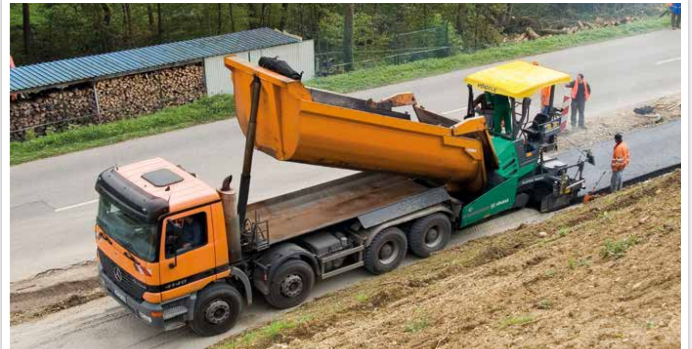
ASPHALTEINBAU BEI GEH- UND RADWEGKOMBINATIONEN
