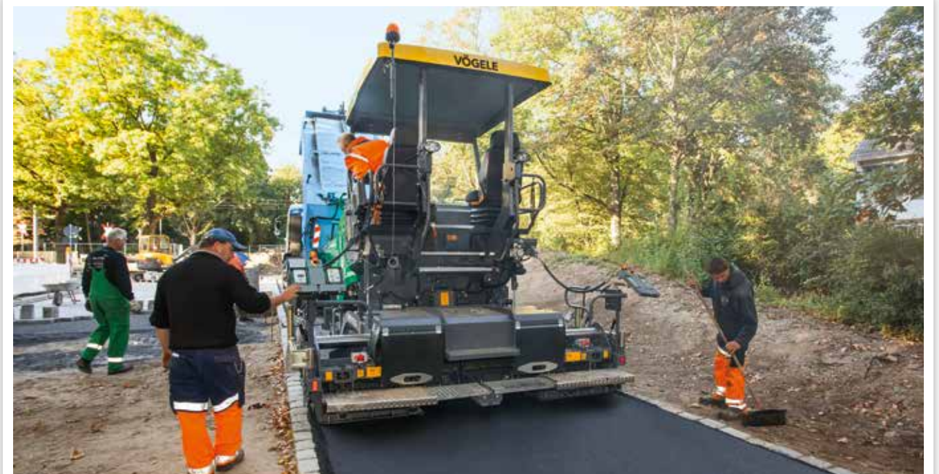
WEGEBAU IN PARKANLAGEN
