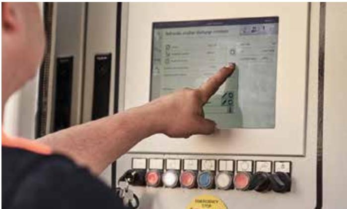
> 通过 SPECTIVE 控制系统启动“锁定转子”命令。
