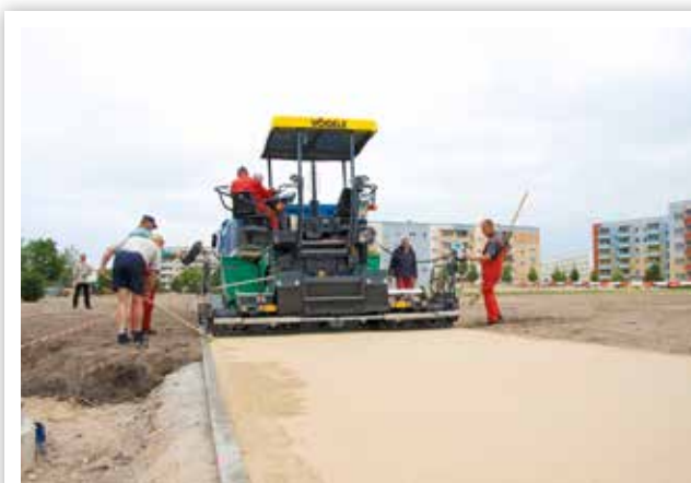
RIPRISTINO DI STRADE D'ACCESSO
