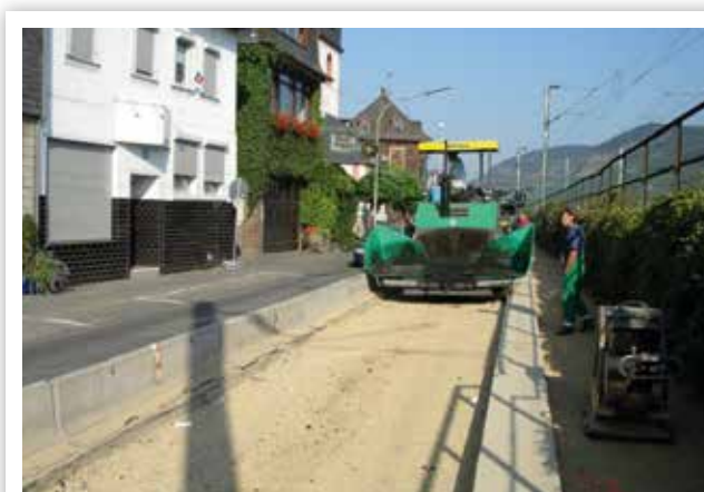
RIPRISTINO DI STRADE COMUNALI
