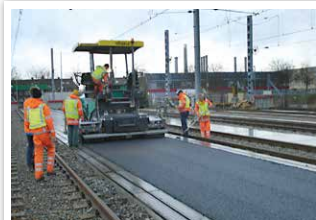
ASFALTATURA DI MARCIAPIEDI FERROVIARI
