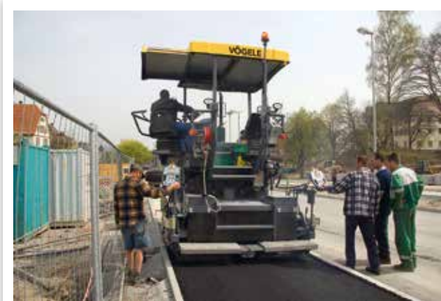
ASFALTATURA DI PISTE CICLOPEDONALI
