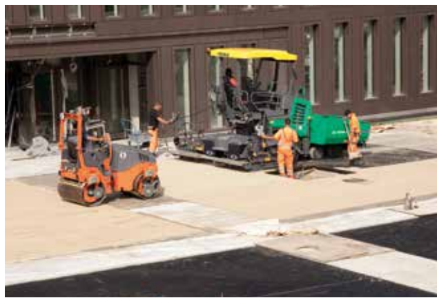
EXTENDIDO DE ASFALTO EN SUPERFICIES UTILIZADAS INDUSTRIALMENTE
