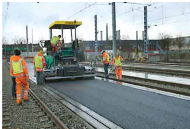
EXTENDIDO DE ASFALTO EN ANDENES
