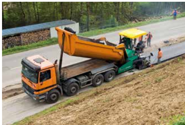
POSE D'ENROBÉ SUR TROTTOIRS / PISTES CYCLABLES COMBINÉS
