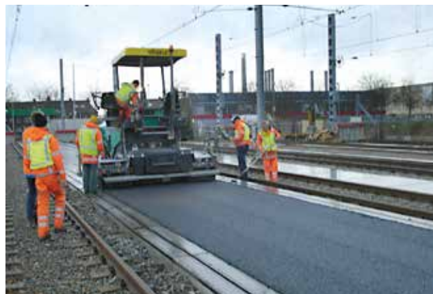
POSE D'ENROBÉ SUR LES QUAIS DE GARE
